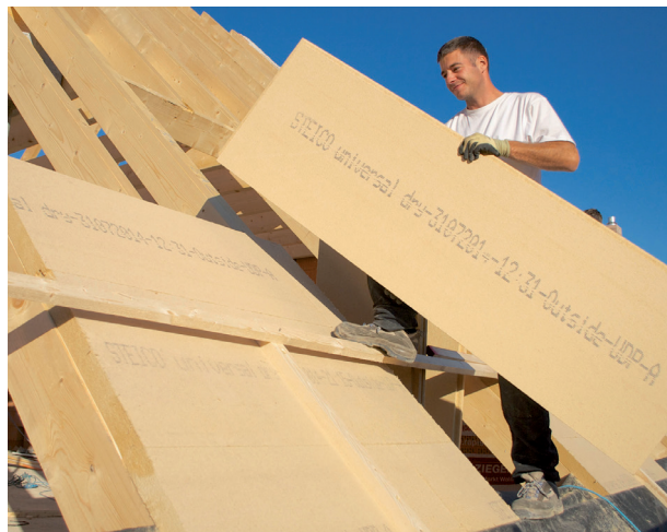
Dämmung aus Weichfaserplatten
