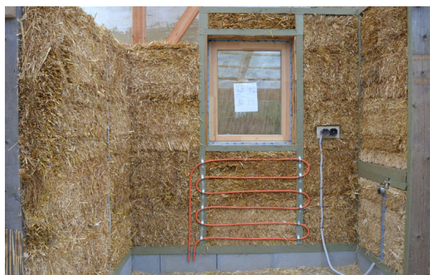
Leitungsverlegung an einer Strohwand
