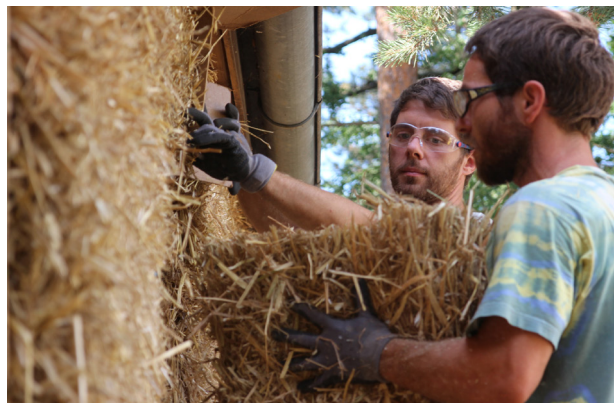
Einbringen von Strohballen ins Fachwerk
