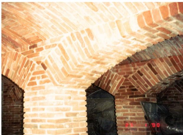
Tragkonstruktion aus Arkaden- und Segmentgewölbe
