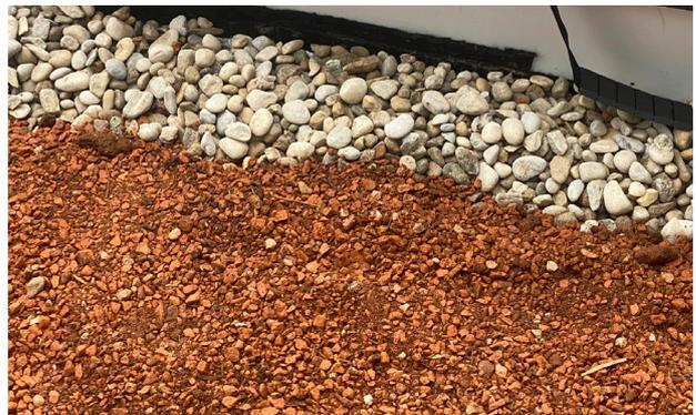
Recyliertes Material wird auch als Dachsubstrat verwendet.
