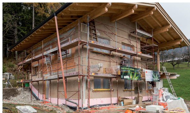
Fassadendämmung mit Hanf-Platten
