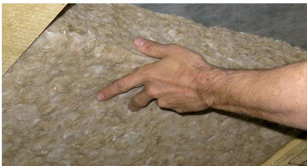
Flachs als Innendämmung Dachstuhl
