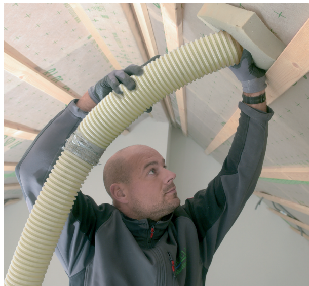
Einblasen des Dämmstoffs
