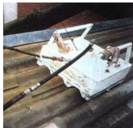
Dadurch werden Verschmutzungen, Moose, Flechten und lose Teile (Asbestfasern, Zementteilchen usw.) abgeschwemmt. Das, über die Dachrinne ablaufende und mit Asbestfasern angereicherte Brauchwasser darf nicht direkt in die Kanalisation geleitet werden, sondern muß nach den Vorschriften der zuständigen Stelle (z.B. in Wien Magistratsabteilung 22, in den Bundesländern die jeweilige Landesbehörde) einer Filteranlage mit abgeschlossenem Entsorgungsteil zugeführt werden. Die Entsorgung der asbest-
